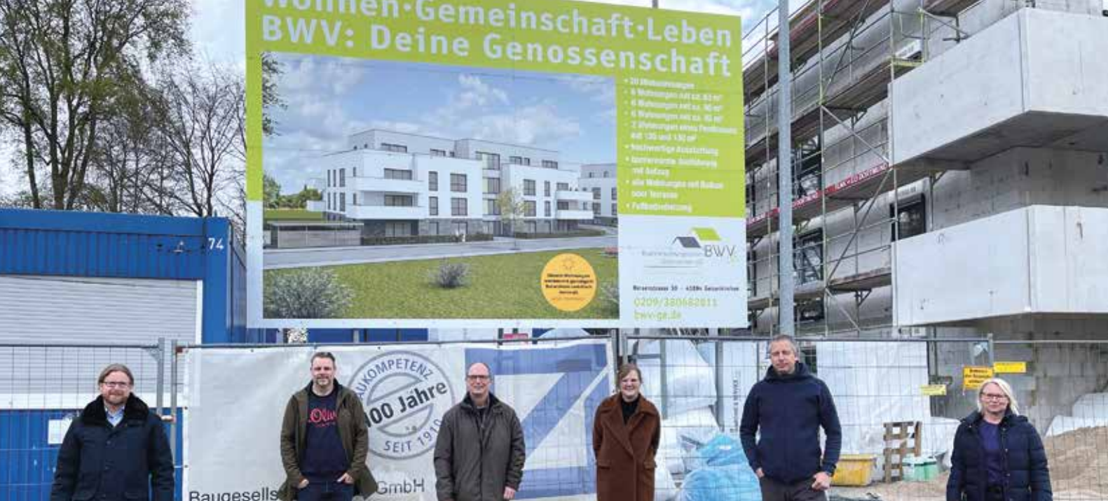
Immer wieder vor Ort: Vorstand (V) und Aufsichtsrat (AR) begutachten den Baufortschritt. Von links Johannes Heinrich (V), Kolja Maletzki (AR), AR-Vorsitzender Klaus Holm, Sonja Menze (AR), Torsten Bannuscher (AR) und Katrin Kornatz (V).
