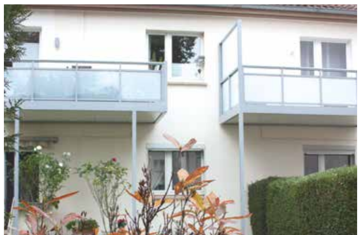
In den letzten Jahren wurden etliche Wohnungen beim Genossenschaftlichen Schalker Bauvereins erstmals mit Balkonen ausgestattet. „Das ist fast wie ein weiteres Zimmer“, freute sich ein Mitglied.
