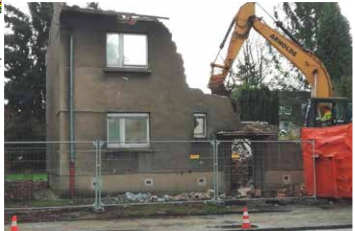
Eine erste Skizze der geplanten Häuser (oben) und der Abriss des alten Hauses (rechts).
