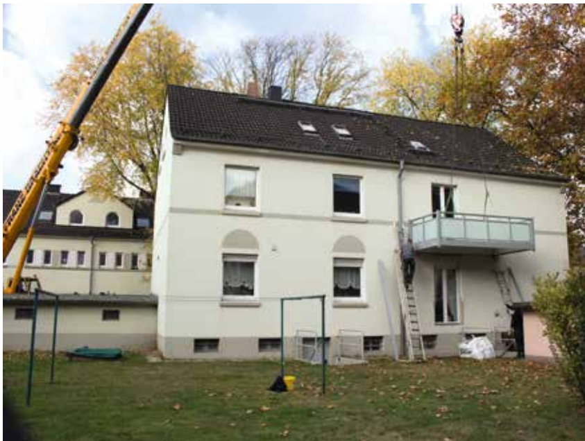
Ein eingespieltes Team baute die Balkone professionell auf, dann kamen sie an den Haken, wurden ans Haus gehievt und hier verankert.
