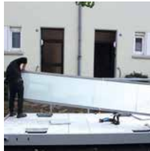
Ein eingespieltes Team baute die Balkone professionell auf, dann kamen sie an den Haken, wurden ans Haus gehievt und hier verankert.
